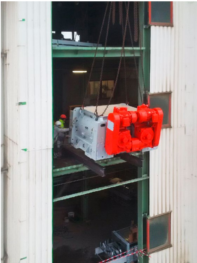
Einbau eines neuen Trockenstoff-Chargenmischers DMX 2600 mit Doppelklappe zur Modernisierung eines Trockenstoffwerks
